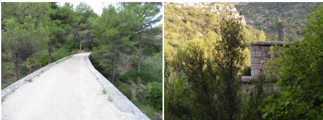
Esquerra, pont de pedra. Dreta, antic pont de ferro a dia d'avui desmantellat. Font: pròpia
